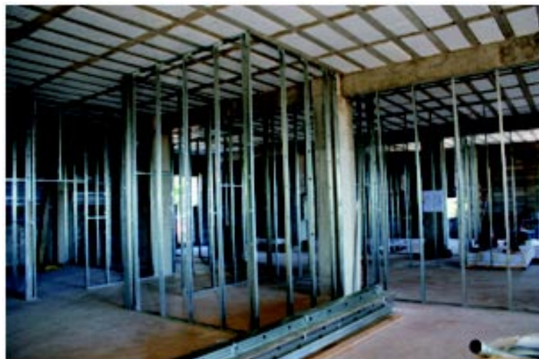
Construção hospitalar com instalação da estrutura painéis de paredes em DRYWALL.
