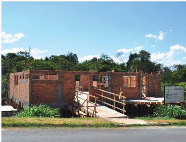
A nova sede está sendo construída na Avenida Orestes Gonzaga
